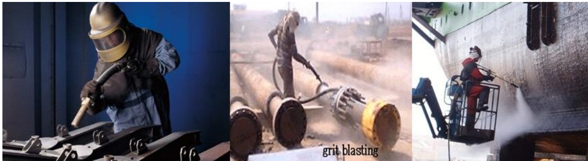
شکل ۲: روش ایربلاست در پرتاب مواد ساینده
